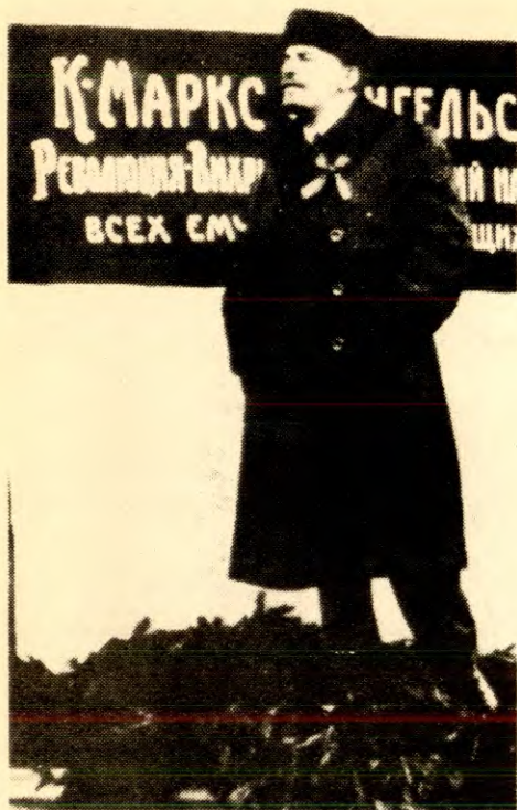
Lenin taler ved avdukinga av minnesmerket over Marx og Engels 7. november 1918.
